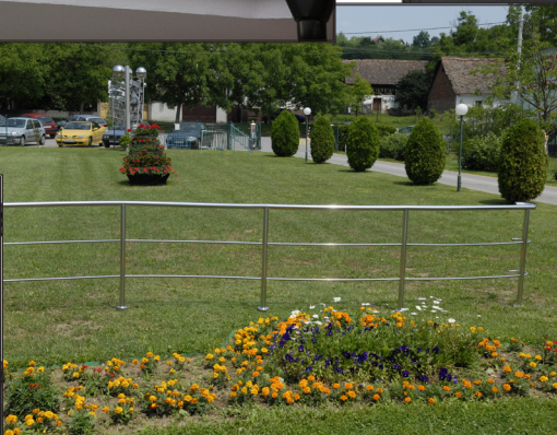
Inox ograda sa dvije ispune promjera 20mm. Stupovi i rukohvat izrađeni od cijevi promjera 50mm.
