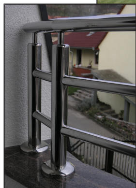
Inox ograda sa dvije ispune promjera 20mm. Stupovi i rukohvat izrađeni od cijevi promjera 50mm.
