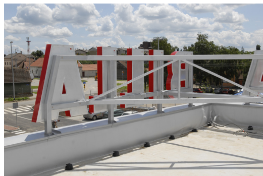
Čelična konstrukcija s logom BILLA
